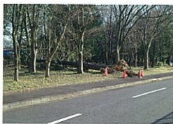
ベッコウタケにより根が腐朽したユリノキの倒伏
