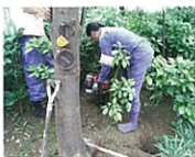
オーガー掘削
