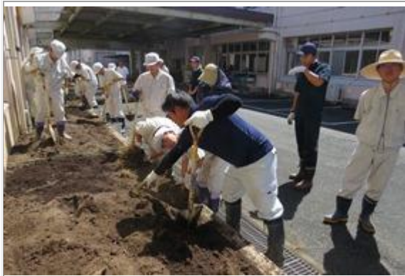
土の中にある草の根を取り除きます。
