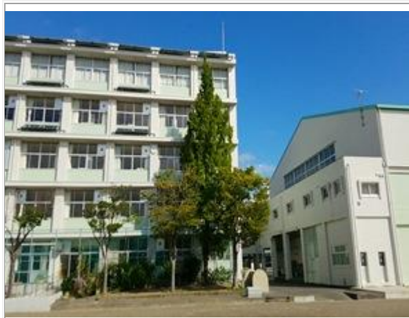
大きくなって落ち葉などの管理が大変になったメタセ
