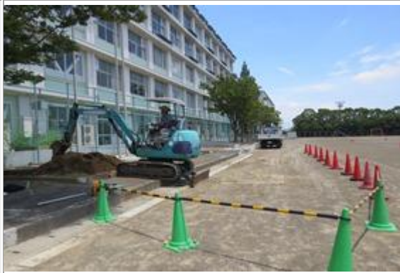
この日は陸上教室が開かれ、生徒さんがグラウンドを走っていたので、作業現場はコーンで囲みました。
