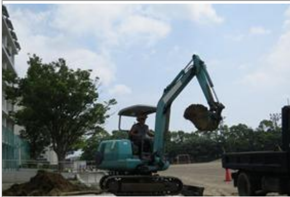
掘削した土はダンプに積み込み、空港近くの残土処理場まで運搬します。
