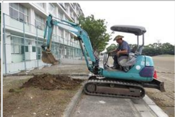
重機で掘削します。コンクリートも破碎し、木の根も除去します。さすがに機械の威力です。
