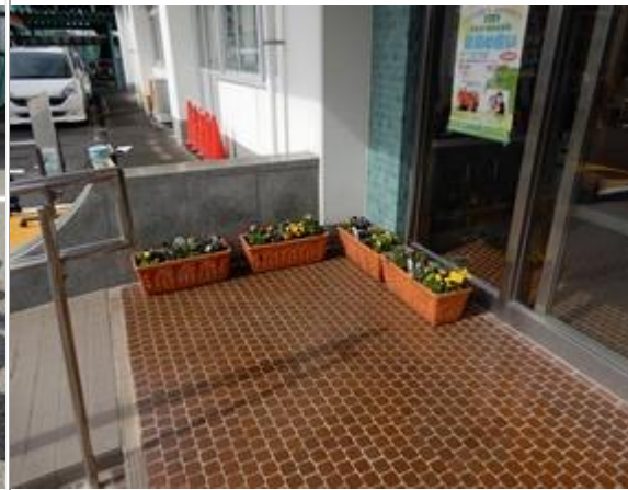
プランターを正面玄関に設置
