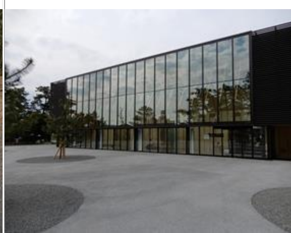
周辺には「三保松原文化創造センター」や 駐車場が綺麗に整備されています
