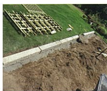
庭の改修工事
