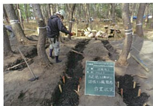
溝切り後の木炭施工
