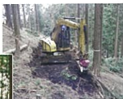
簡易作業車道の施工
