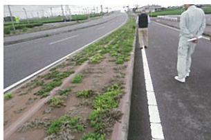
静岡空港アクセス道路
