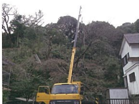
人家裏の大径化した広葉樹の伐採 伊東市宇佐美地内（簡植源施工）
