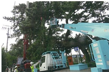
高所作業車とクレーンで伐採
