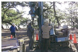
ボーリング機械は自走式のコンパクトなものです。
