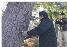
センサーを幹に打ち込み、ハンマーでたたき、パソコンへ無線でデータが送られます。
