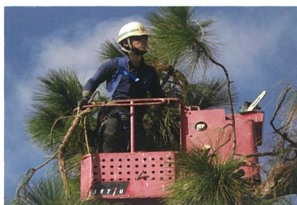
高所作業車を操作し民家の高木を伐採
