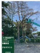
高所作業車による枝払い
