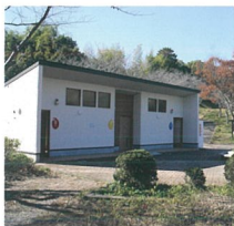
新設したトイレ
