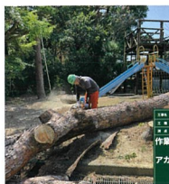
伐倒後の玉切り
