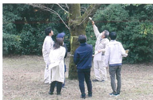
木槌による打検で樹木内部の空洞範囲を確認
