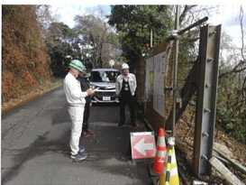
道路改良工事／東部支部 (R8. 3/19)
