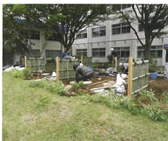
1級受検者（建仁寺垣製作状況）
