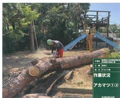
枯れたマツの伐採
