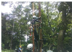
ツリー専用スパイクを装着しての作業訓練
