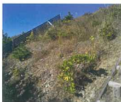
法面上部に植栽した広葉樹
