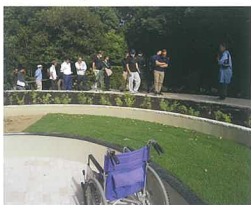
ユニバーサルガーデン施工現場を視察
