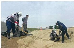
法面緑化工事を施工管理 (左から2番目)
