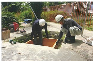
パーゴラの基礎型枠を確認 (右側)
